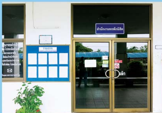
สำนักงานหอพัก
